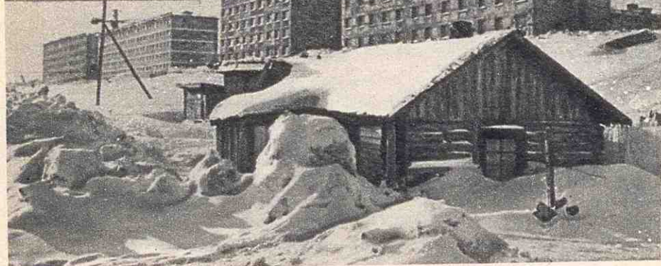
В безлюдной тундре вырос город Заполярный. А начался он с этого маленького деревянного домика, в котором жили строители.
